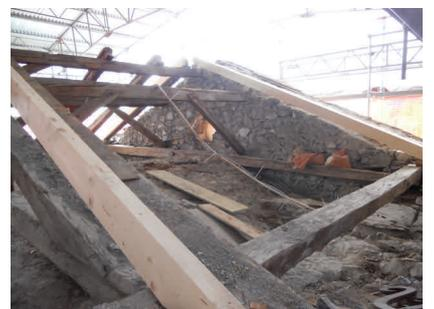
Sablère fortement endommagée : curetage de la pièce, création d'une rainure, coffrage, insertion de barres de fer et coulage de résine de bois (une vingtaine d'interventions de ce type)
