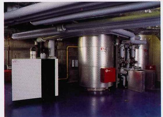
«La chaudière à condensation à gaz de 613 kW servant à chauffer les bureaux et la salle de gymnastique ; à côté, les accumulateurs d'eau chaude sanitaire»
